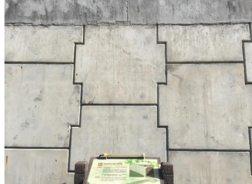
圖二十、預鑄面版式加勁擋土牆
