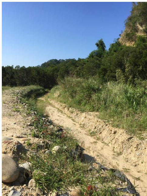
圖二十九、加勁土堤作為土石流的導流堤
