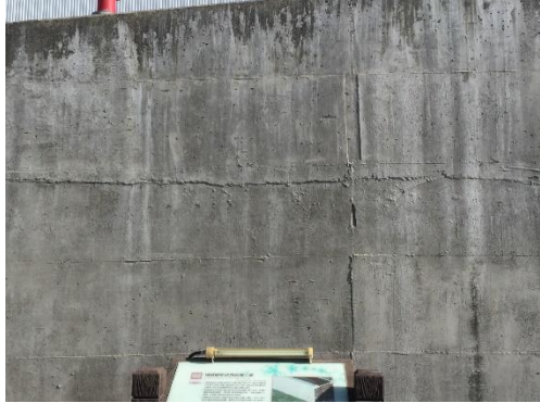
圖十九、場鑄面版式加勁擋土牆
