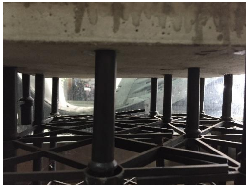
圖十二、 防災空調導水架構
