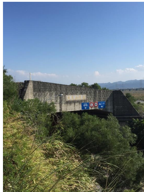
圖三十、火炎山隧道整治後現況
