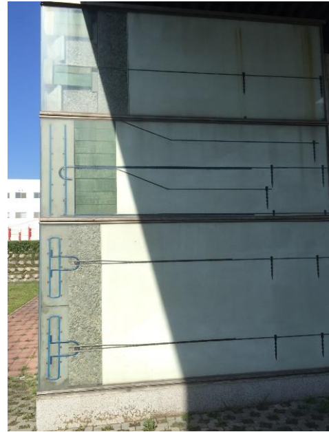
圖十六、鋼柵式加勁擋土牆
