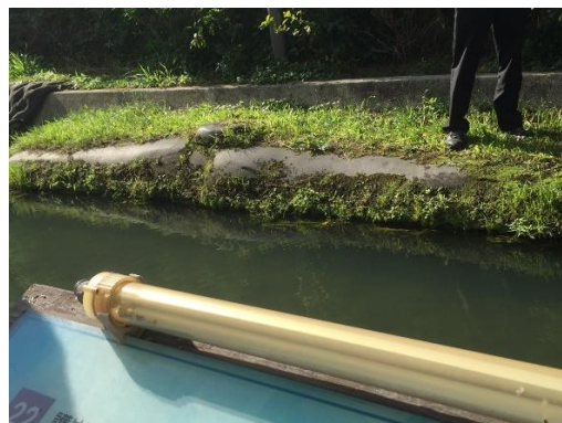
圖二十二、土工砂腸護岸
