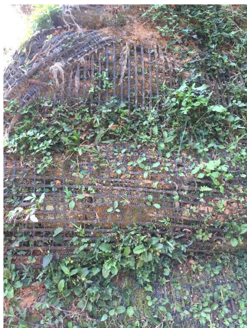
圖二十五、暨大邊坡整治工法(I)
