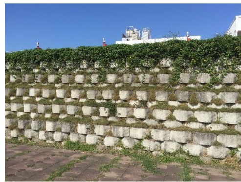
圖十八、景觀石式加勁擋土牆
