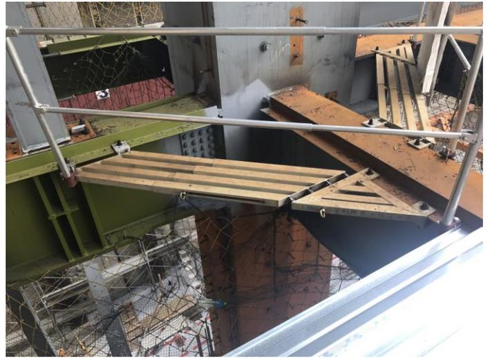
鋼結構專用鋁合金安全走道(AKB)
