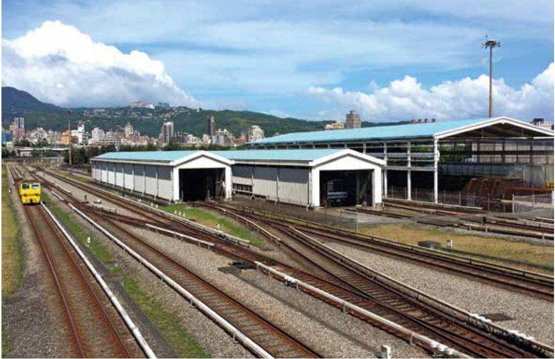
北投機廠是台北捷運首個動工的土木工程 攝影／廖健竣
