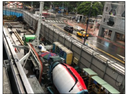
▲ 混凝土車及泵送車
