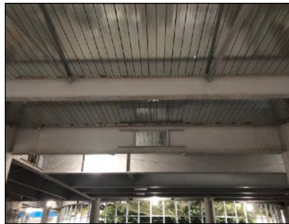
▲ 大梁開口補強
